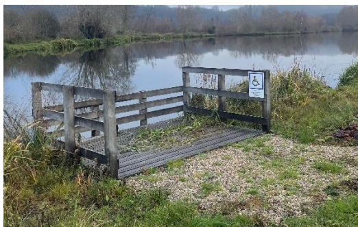
Figure 19 : Exemple ponton accessible PMR
